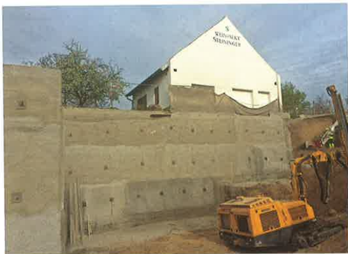
Keller Grundbau entschied sich für eine Baugrubensicherung mittels vernagelter Spritzbetonsicherung.
